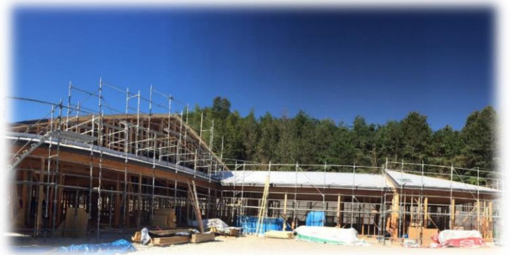
工事中(10月7日現在)
